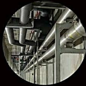
Topografía de túneles de servicios subterráneos
